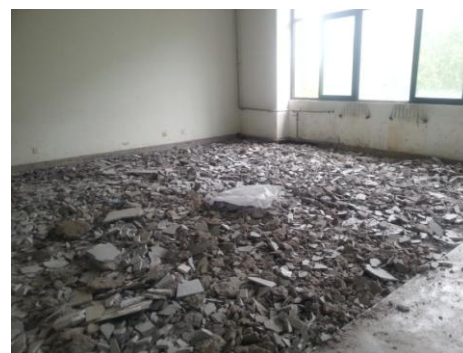
施工产生的渣土
