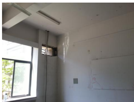
大噪音施工现场（一）
