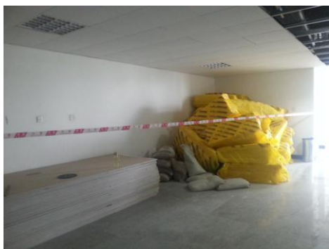
施工现场拉出的警戒线
