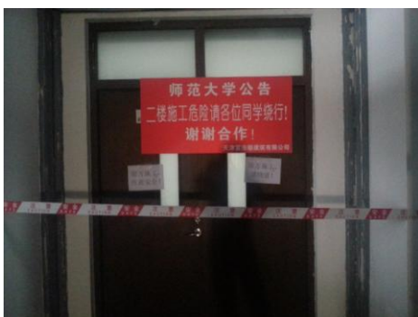
施工现场张贴的警示语
