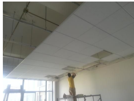
土建工程：安装吊顶
