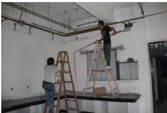
电力工程：安装室内电线套管
