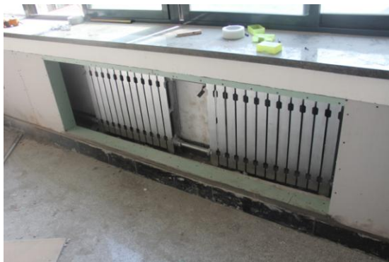
暖通工程：安装暖气罩、粉刷暖气片
