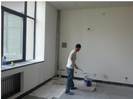
土建工程：内墙刷涂料
