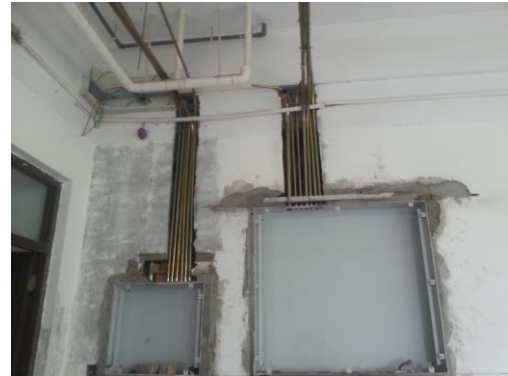
电力工程：安装室内电源开关箱
