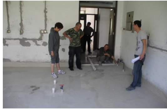
土建工程：防水地面闭水试验开始蓄水
