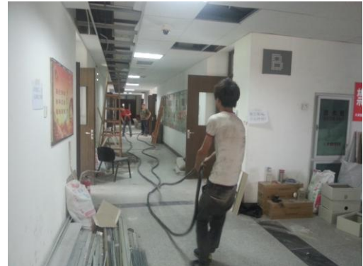
电力工程：铺设室内电缆
