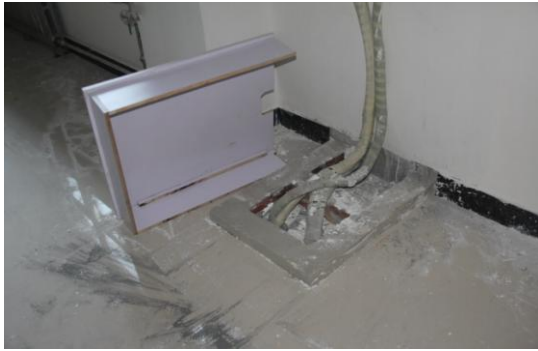
土建工程：安装管道保护罩
