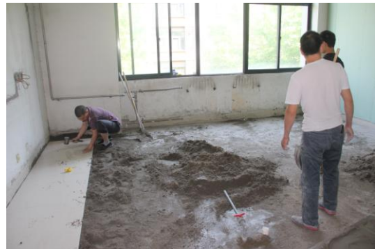
土建工程：铺设地面玻化砖
