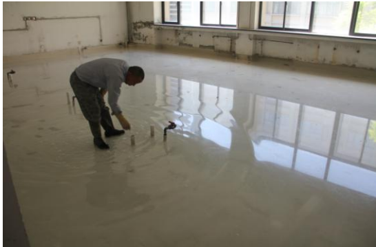
土建工程：防水地面做闭水试验
