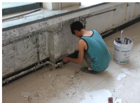
土建工程：安装踢脚板
